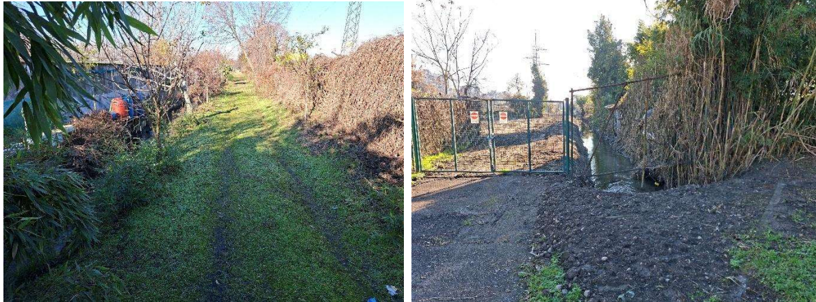
Foto 19: a sx alveo a monte di via Milano e a valle sbocco attraversamento via Milano; a valle di via Milano la roggia è stata ripulita ed è stata risagomata la sponda sx a 11/2025
