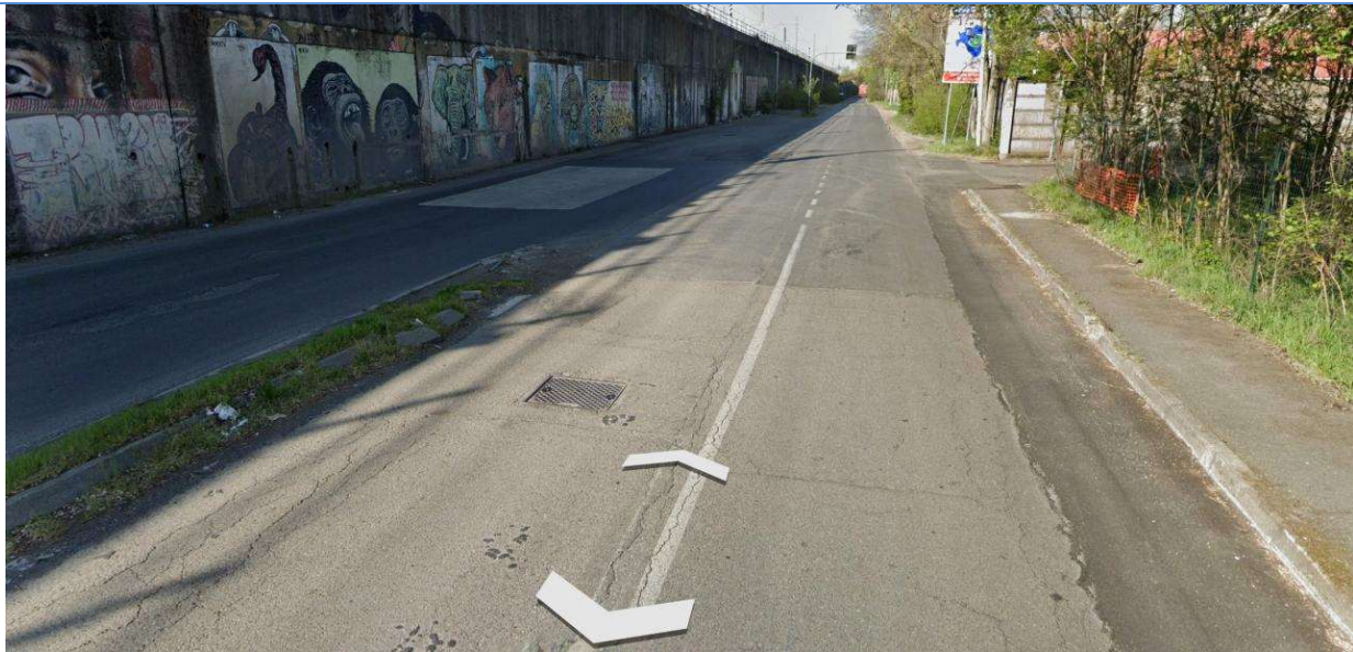
Foto 32: chiuso accesso cameretta dove tombinatura roggia Molina curva a 90° per attraversare gli scali ferroviari; nella medesima cameretta dovrebbe ricevere tubazione del fontanile Seminario (da verificare)
