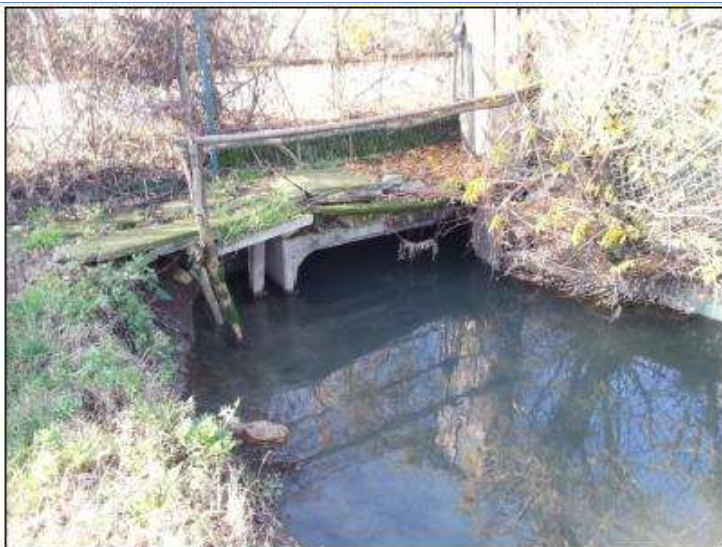
Foto 21: vista imbocco attraversamento CESI (3) (fonte DOC4)
