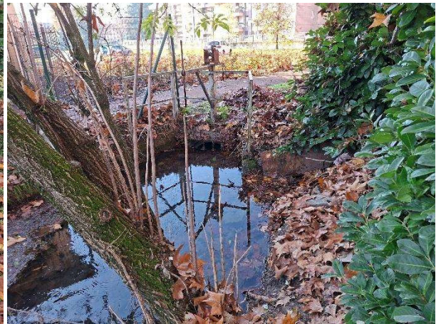
Foto 36: imbocco tombinatura punto 3 a 12/2025; la griglia è intasata dal fogliame e l'imbocco è completamente sommerso
