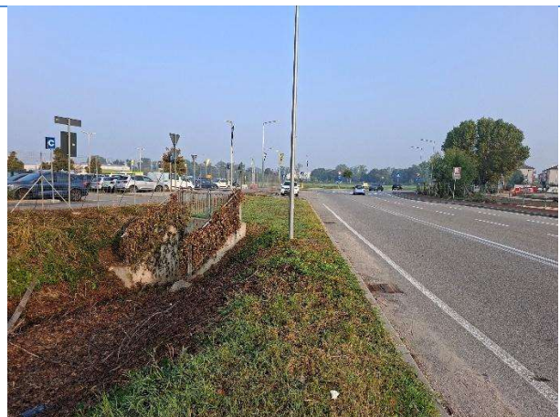
Foto 45: a sx imbocco e a dx sbocco tombinatura di attraversamento via Jannacci (tratto 7-8)
