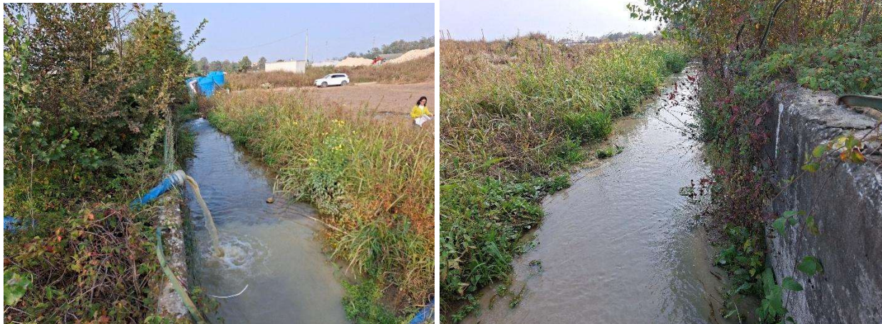
Foto 52: scarichi well point Nuova Cassanese al punto 1; a sx vista verso monte; a dx vista verso valle
