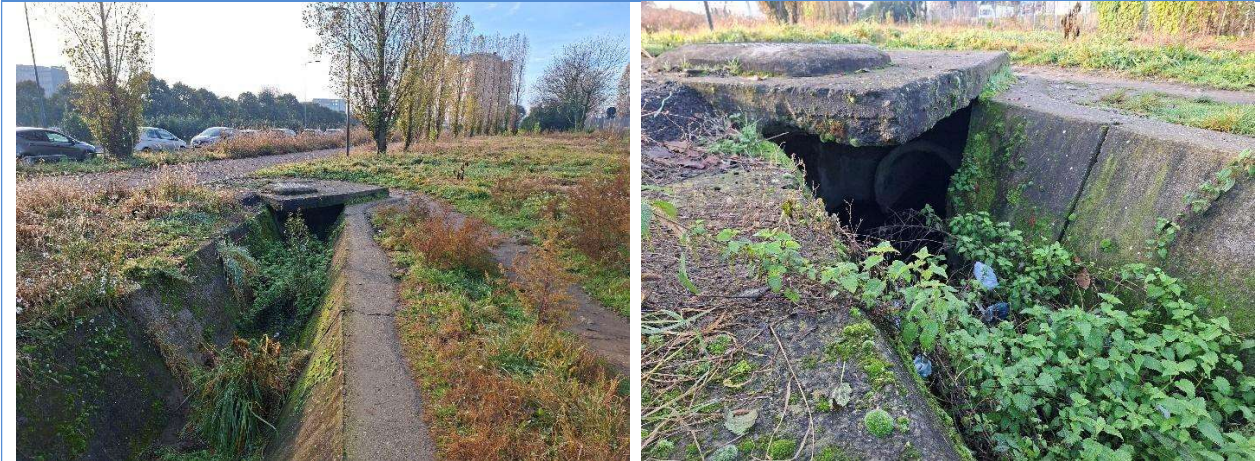
Foto 1: imbocco tombinatura circolare 2x1200
