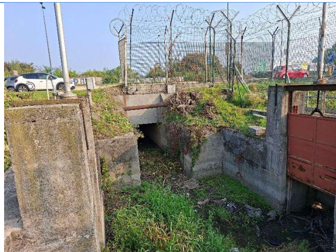
Foto 49: sbocco nel cavo Lirone dell'attraversamento di viale Forlanini (12)
