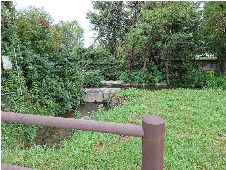
Foto 62: ponte canale del Canale Adduttore B sul Commendino; oltre la zona industriale in cui il Commendino è tombinato
