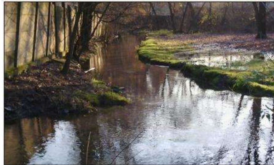
Foto 9: a sx imbocco 39; a dx sbocco 29 nel parco Lambro; sotto (fonte DOC4) guardando da 29 verso valle con sponda h30 cm; sullo sfondo a dx il muro del Cimitero di Lambrate
