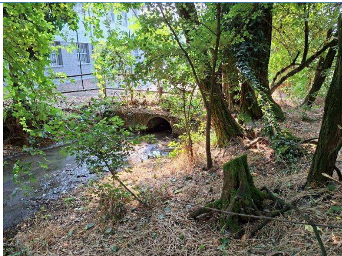
Foto 24: vista imbocco via Fermi 25
