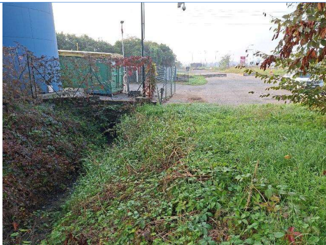
Foto 57: imbocco attraversamento accesso alla centrale termica San Felice
