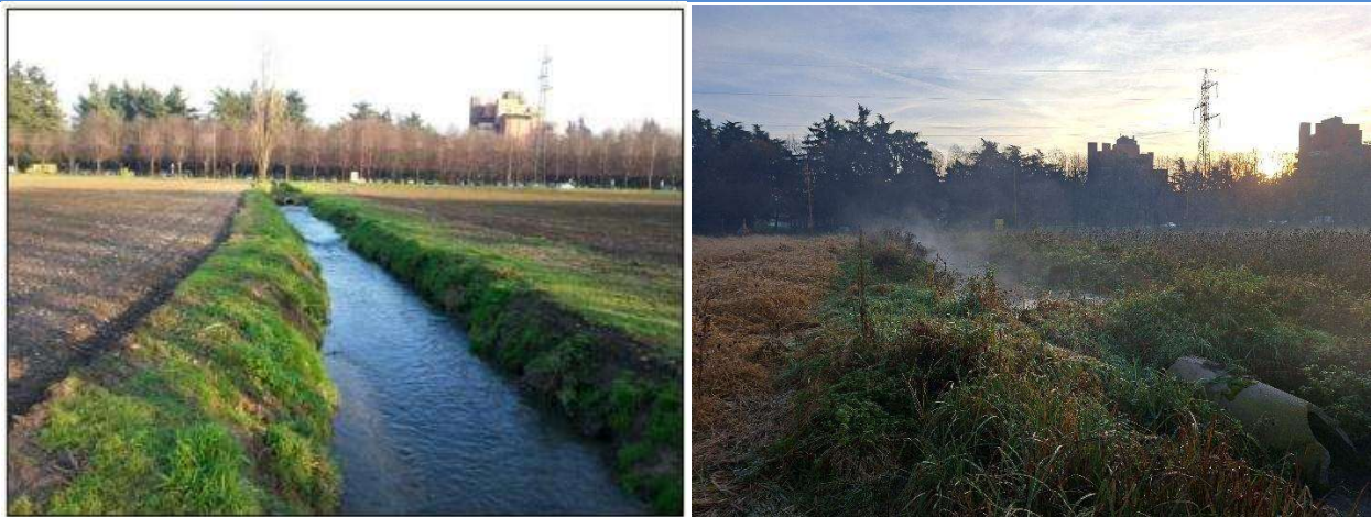
Foto 7: a sx (fonte DOC4) vista da via Fratelli Cervi verso 34; si vede il tubo cls 500 in 34-33; a dx il tubo rotto a 12/2025
