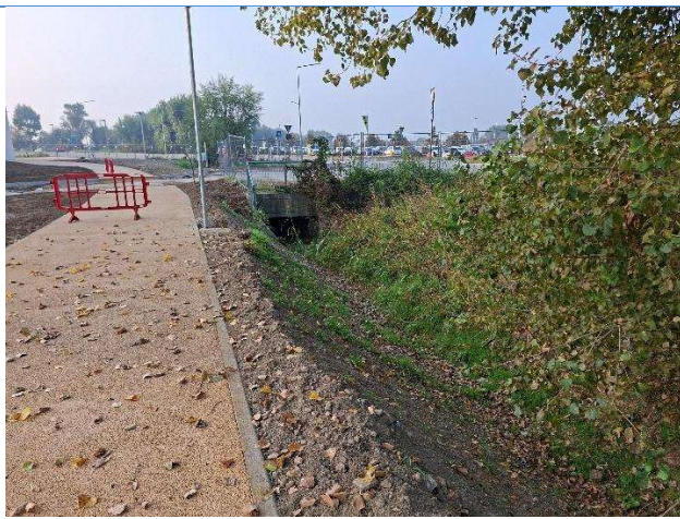
Foto 44: imbocco attraversamento di accesso da via Jannacci nelle aree a Est (5)
