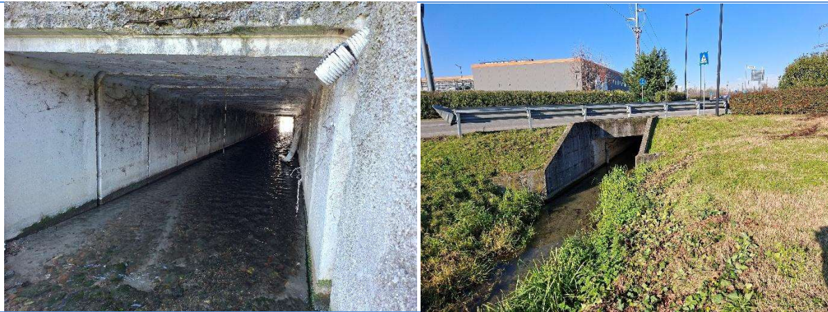
Foto 17: vista imbocco 12 e sbocco 11 attraversamento rotonda incrocio via Lambretta-via Piaggio
