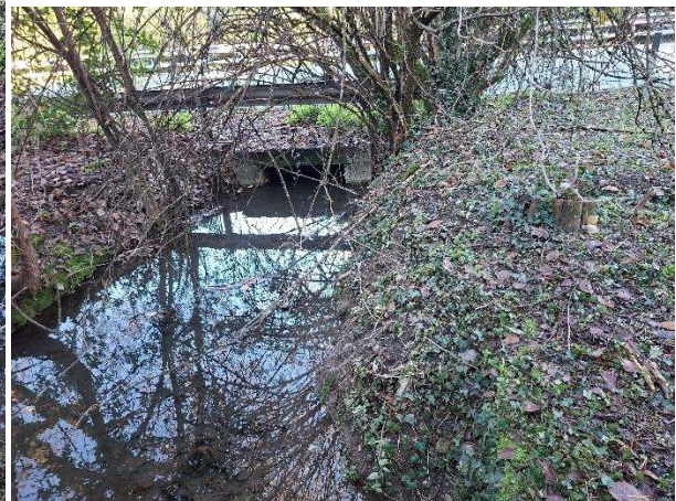
Foto 36: imbocco tombinatura punto 3 a 12/2025; la griglia è intasata dal fogliame e l'imbocco è completamente sommerso
