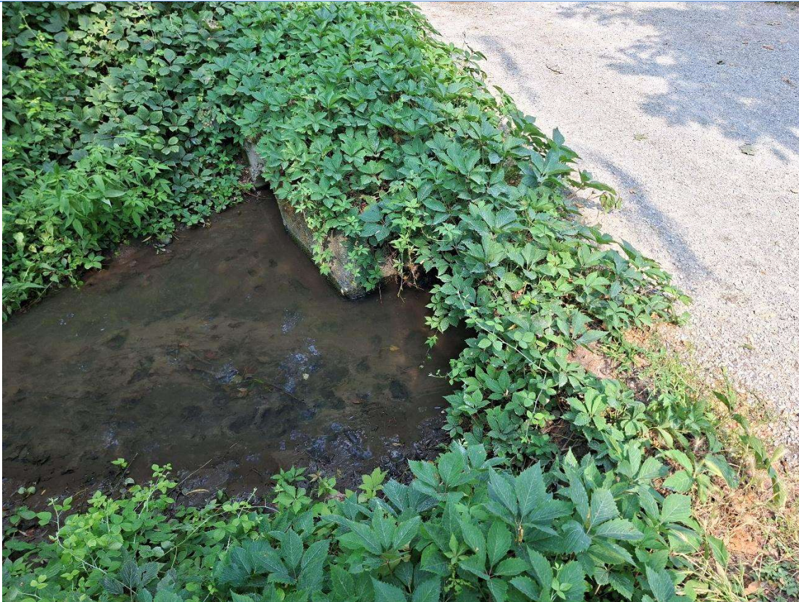
Foto 23: vista imbocco attraversamento 28.5
