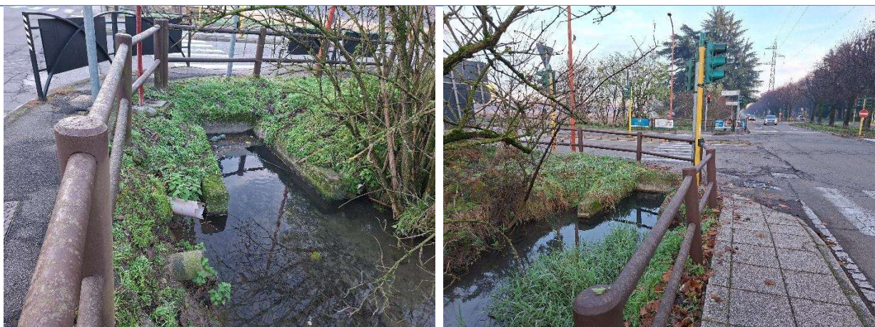
Foto 6: imbocco e sbocco attraversamento viale Turchia
