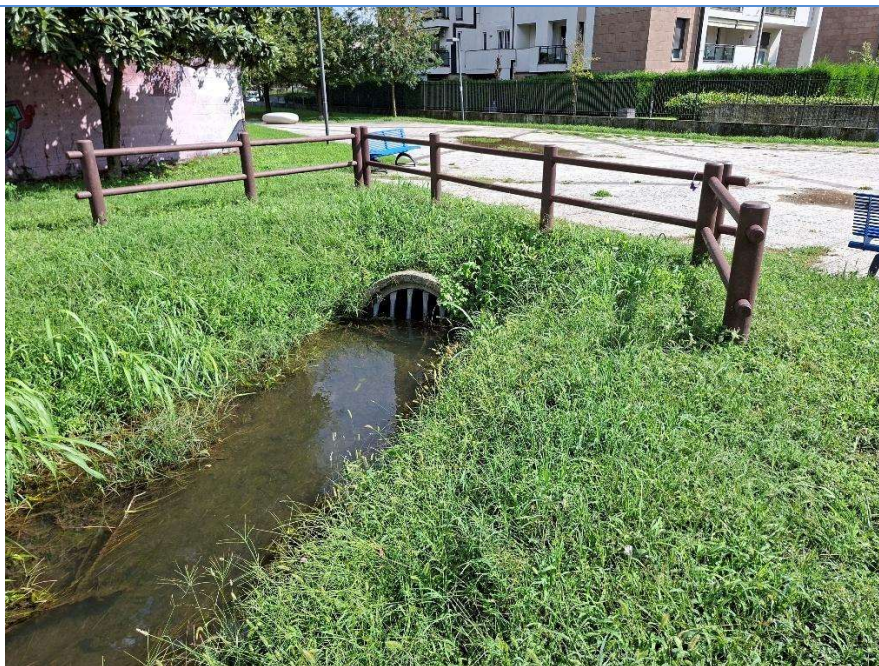
Foto 60: imbocco tombinatura a valle del Parco; è previsto l'abbandono della tombinatura e la deviazione del Nirona nel Canale Adduttore B
