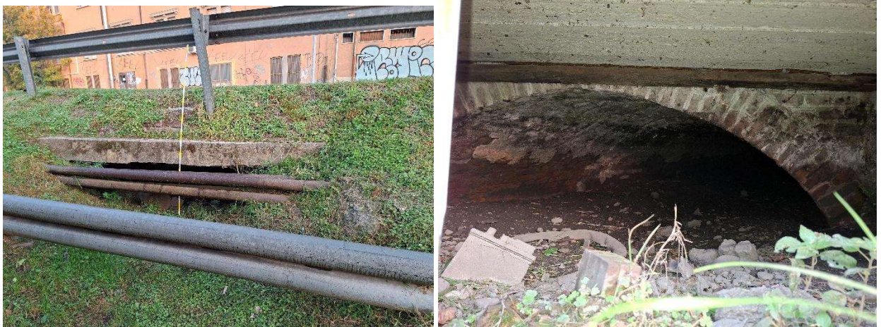
Foto 39: sbocco su via Rivoltana dell'attraversamento scali ferroviari (2)
