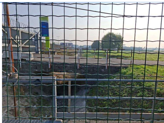
Foto 51: cavo Lirone guardando verso Est dal punto (12) di affluenza del cavo Novegro
