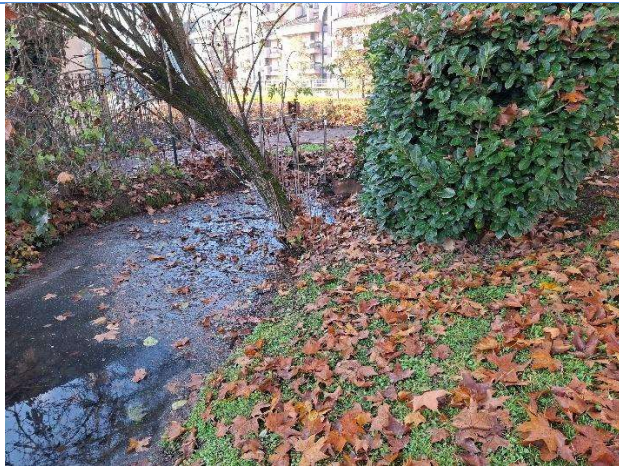
Foto 36: imbocco tombinatura punto 3 a 12/2025; la griglia è intasata dal fogliame e l'imbocco è completamente sommerso
