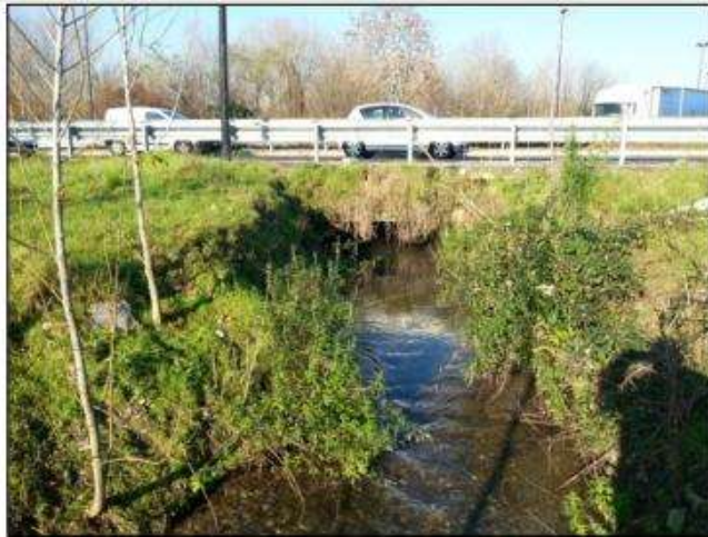
Foto 13: vista sbocco tombinatura Cassanese 23 (fonte DOC4)
