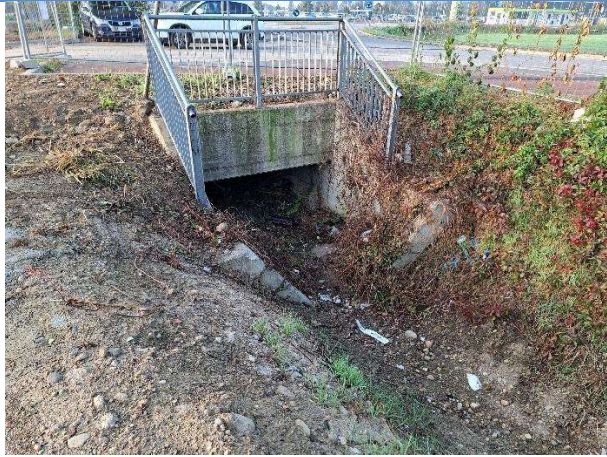
Foto 43: imbocco attraversamento di accesso da via Jannacci nelle aree a Est (4)
