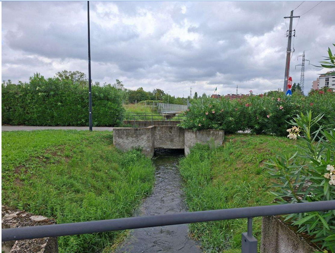
Foto 15: vista da 16 verso monte
