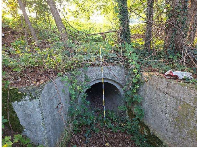
Foto 46: sbocco attraversamento appena a monte del recapito nel cavo Novegro (9)
