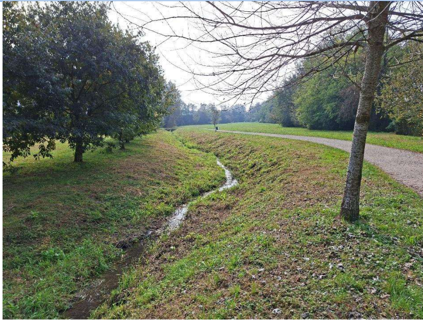
Foto 61: fontanile appena a valle della derivazione dal Canale Adduttore B
