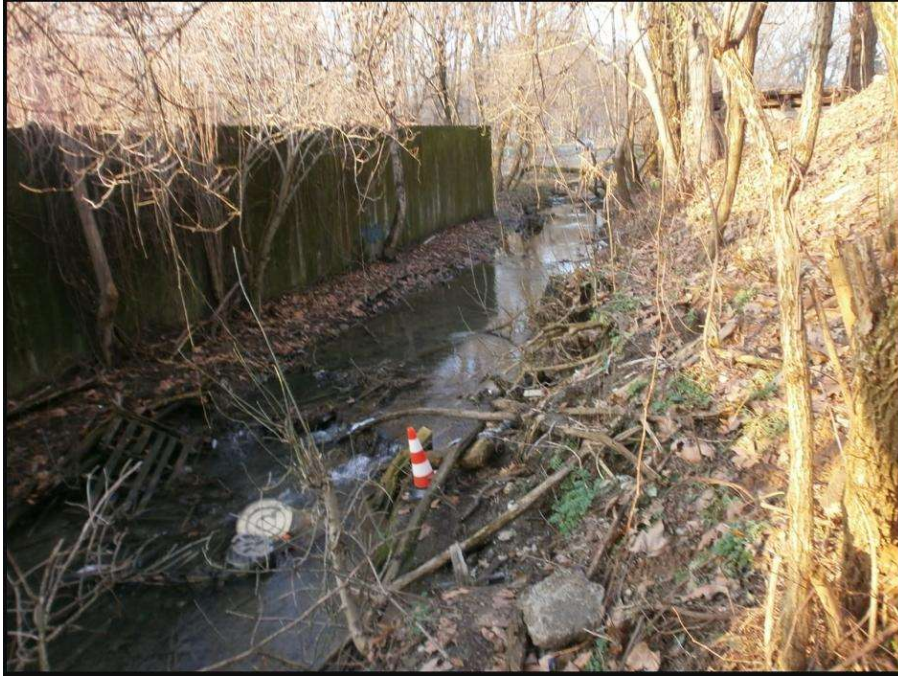
Foto 10: guardando da 28 verso monte dalla zona del punto di scarico 2237 della tubazione DN 200 del pompaggio misto di Milano 2
