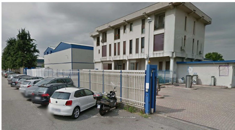
vista ingresso da via Cassanese
