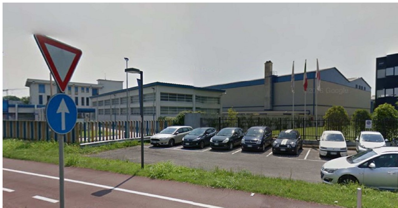
vista ingresso da via Leonardo da Vinci
