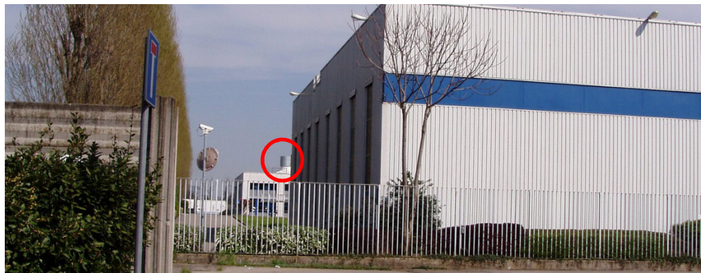
Figura 16 Vista dal confine ovest dello stabilimento Roche.
