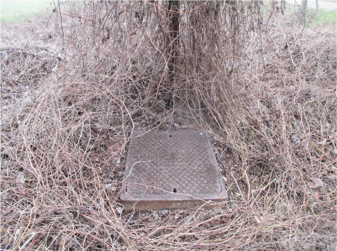
*Figura 15: copertura del pozzetto rete telefonica*
