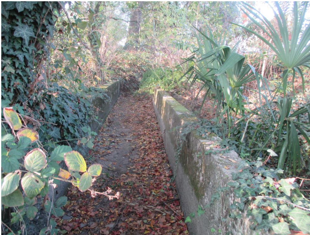
Foto 4: Manufatto in cmt che attraversa il Fontanile in senso est-ovest, visto da Est
