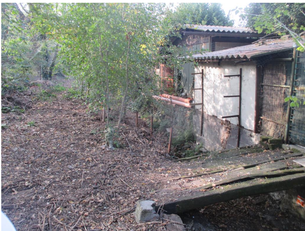
Foto 6: corso d'acqua con ponte in traversine e sponda destra costituita da muro di manufatto
