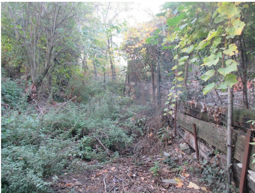
Foto 7: corso d'acqua con sponda destra costituita da recinzione in legno e rete metallica Proseguendo in direzione Sud, il corso d'acqua, di larghezza circa 1 m, con sponde alte circa 80 cm, si allarga fino a raggiungere un alveo largo circa 2 m con sponde che si innalzano ma con inclinazione minore. La vegetazione arbustiva diventa molto fitta (foto 8 e 9).
