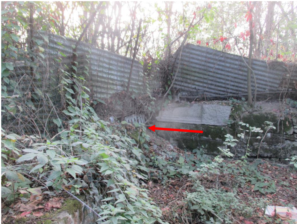
Foto 10: punto di deviazione verso Est del tracciato del Fontanile con passaggio in parte ostruito da grata rudimentale e recinzione in cemento e lamiera (immagine ripresa da Nord)
