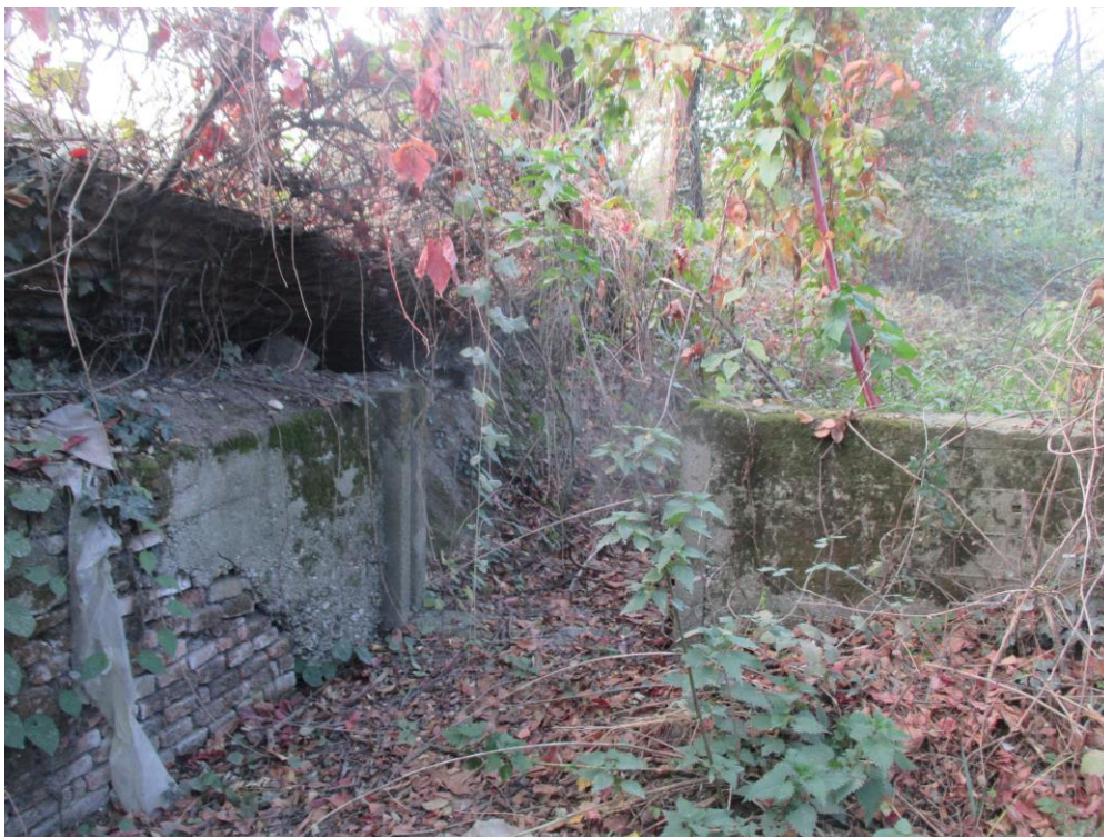
Foto 11: apertura lungo il lato di recinzione Ovest e inizio Roggia Molina (foto ripresa da Est)
