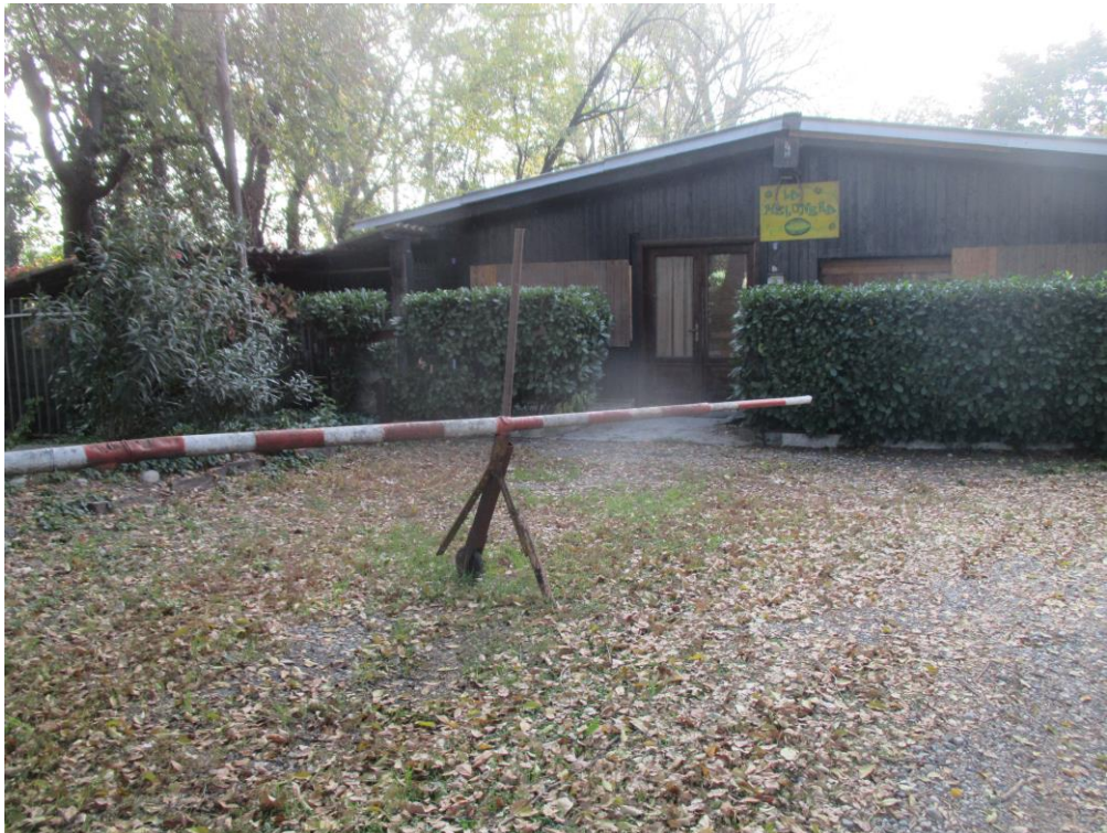
Foto 2: fronte Nord dell'edificio in zona Testa del Fontanile
