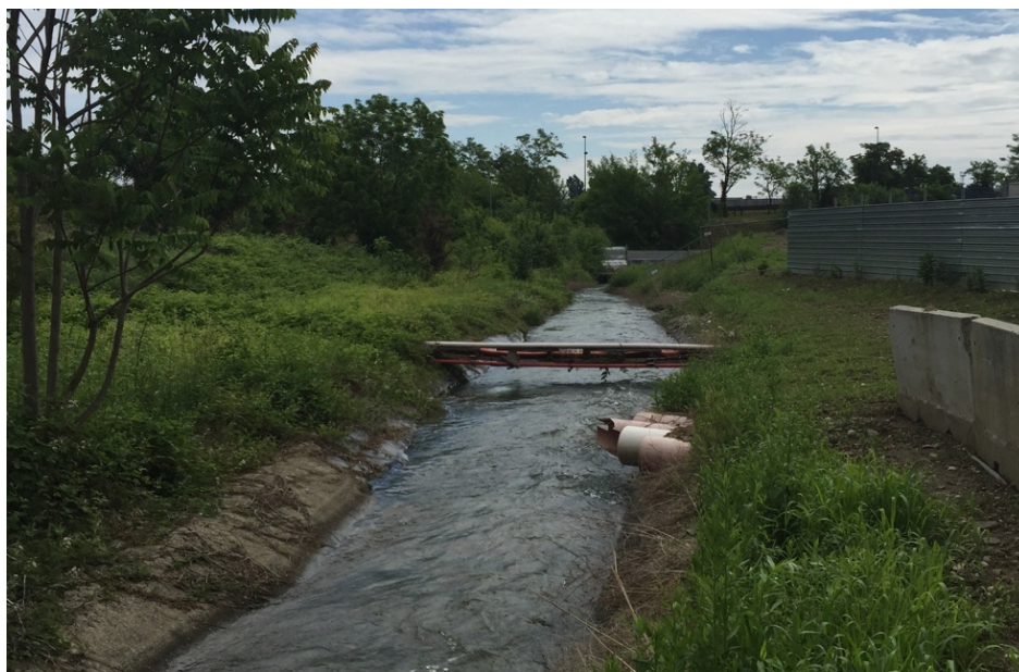
Foto n. 1 | Canale adduttore A – Tratto a valle del tronco intubato
