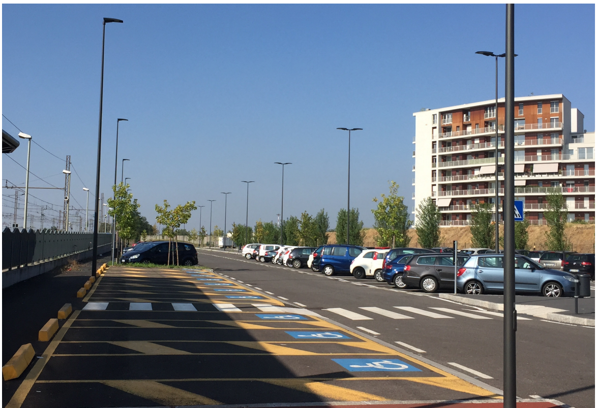
Figura 23 | Stato di fatto via Botticelli – settembre 2016
