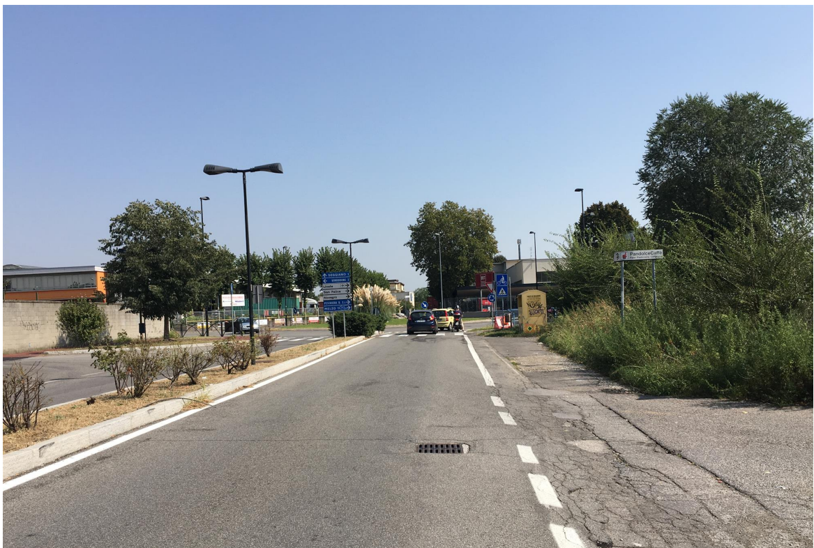
Figura 24 | Stato di fatto Via Botticelli – settembre 2016.
