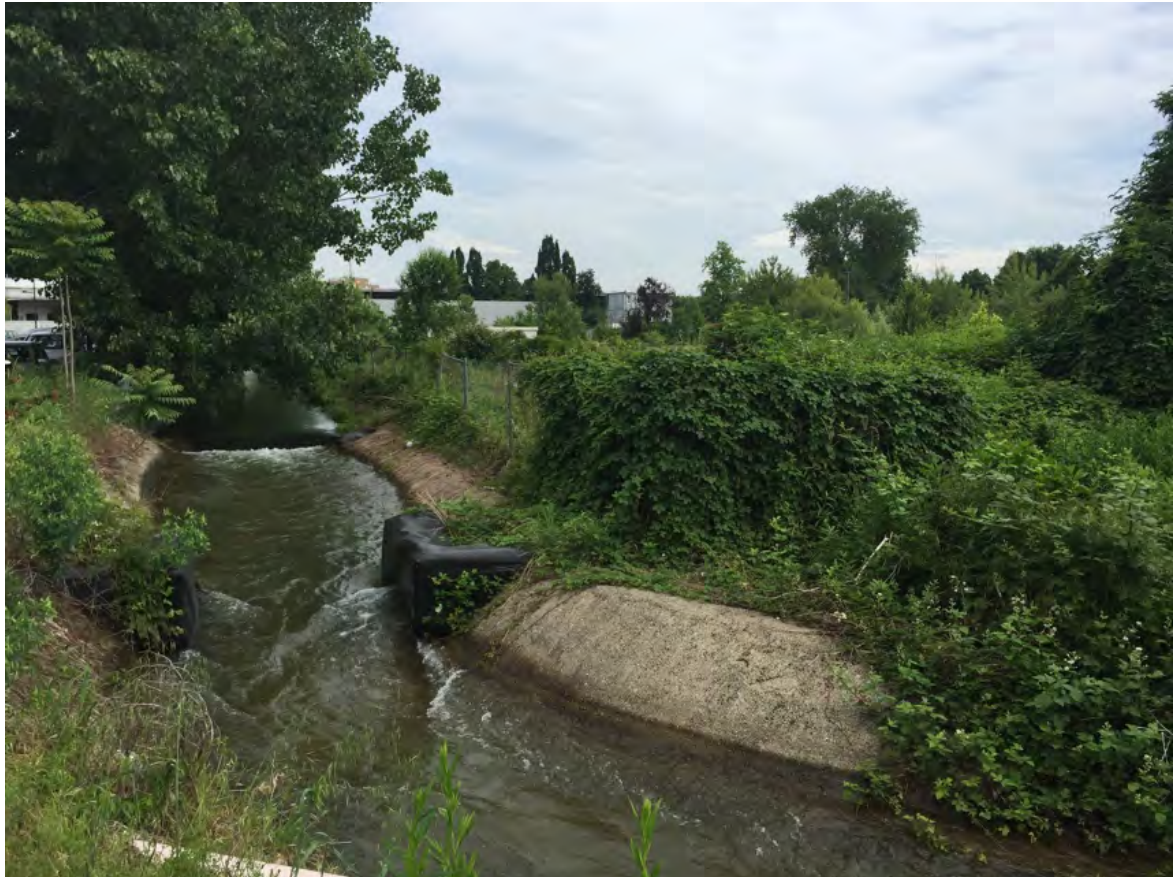
Foto n. 2 | Canale adduttore A - Tratto presente dell'area del PII
