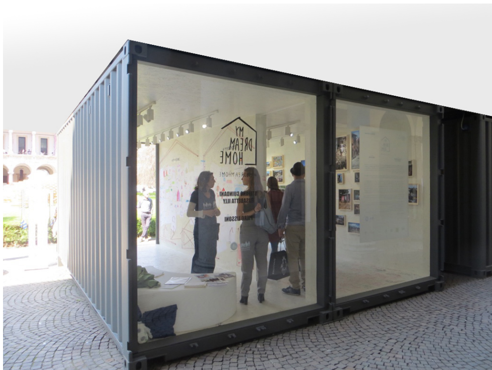
Figura 4-2 | Esempio di manufatto con container accostati.
