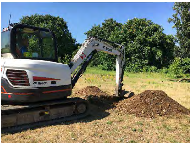
Fotografia 11 – Esecuzione Trincea T6
