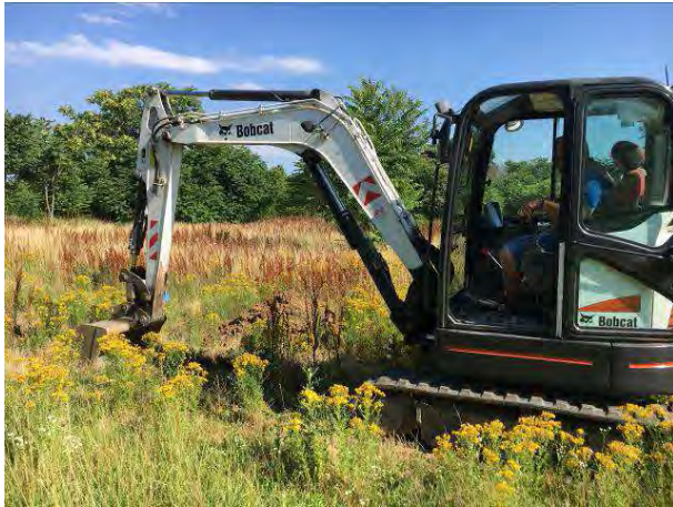
Fotografia 7 – Esecuzione Trincea T4
