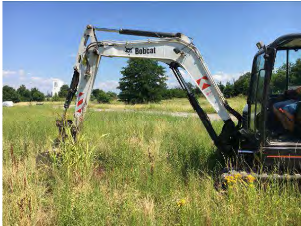
Fotografia 19 – Esecuzione Trincea T10
