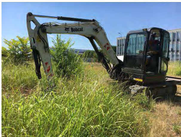
Fotografia 29 – Esecuzione Trincea T15
