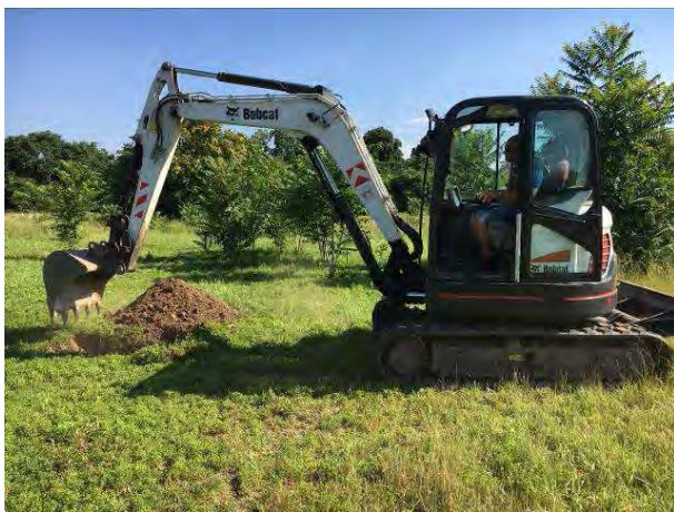
Fotografia 9 – Esecuzione Trincea T5
