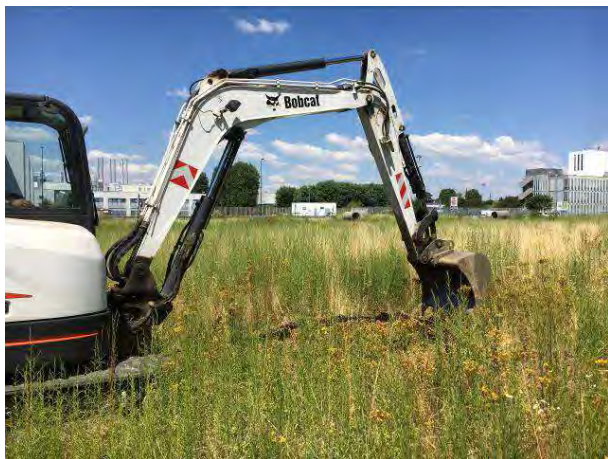
Fotografia 23 – Esecuzione Trincea T12
