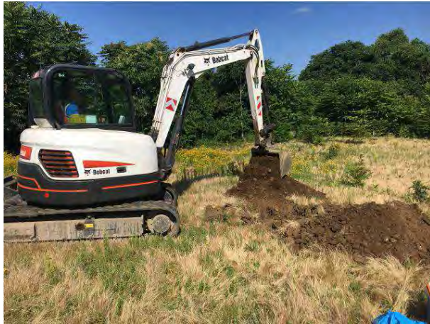
Fotografia 13 – Esecuzione Trincea T7
