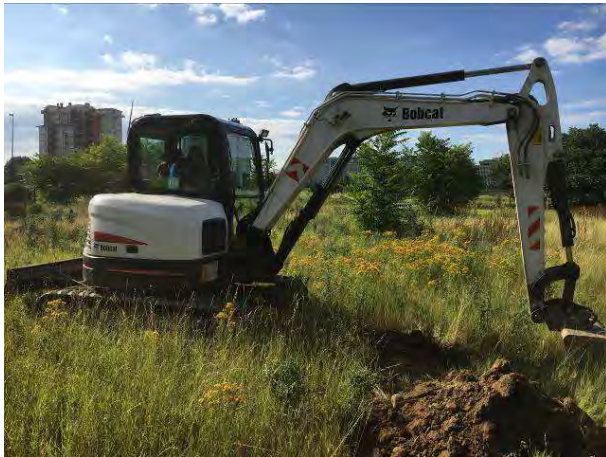
Fotografia 3 – Esecuzione Trincea T2
