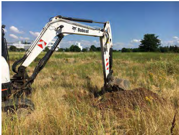
Fotografia 17 – Esecuzione Trincea T9
