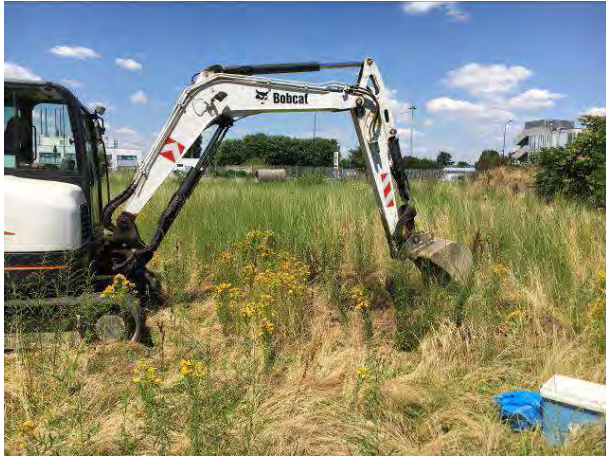
Fotografia 25 – Esecuzione Trincea T13
