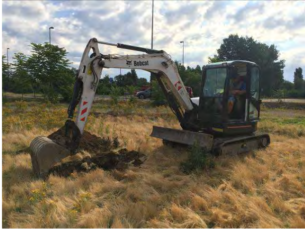
Fotografia 1 – Esecuzione Trincea T1
