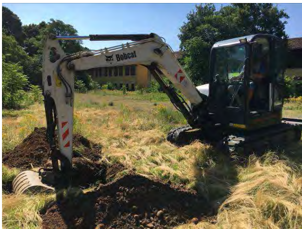
Fotografia 15 – Esecuzione Trincea T8
