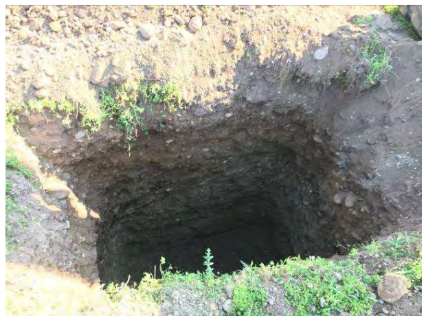
Fotografia 10 - T5 da 0.0 a 3.0 m da p.c.
