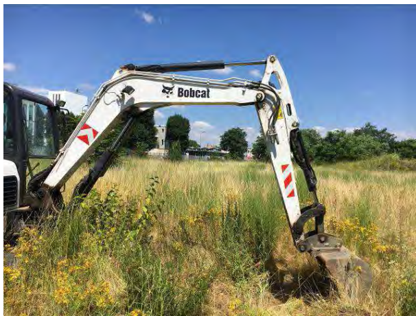
Fotografia 27 – Esecuzione Trincea T14
