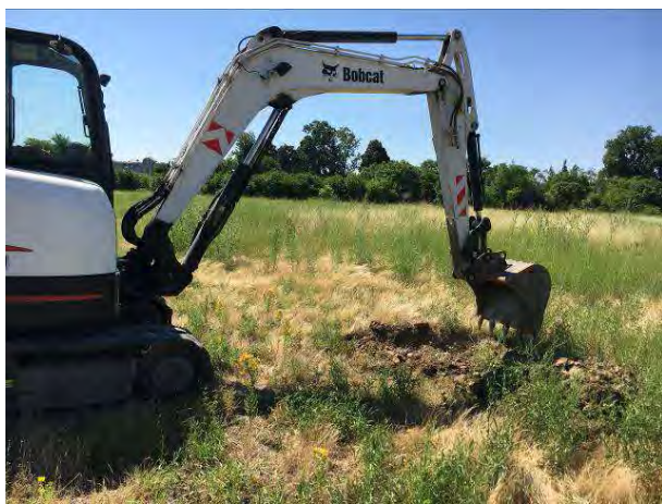
Fotografia 21 – Esecuzione Trincea T11
