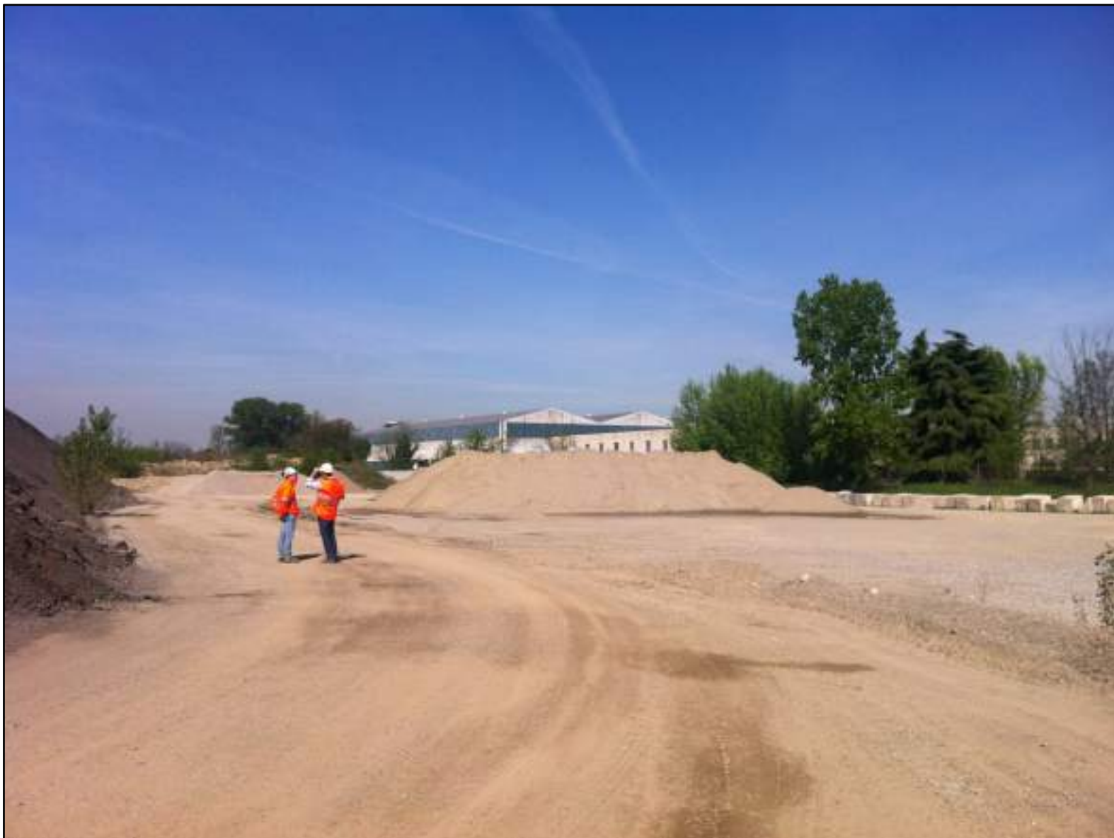
FOTO 16 - VEDUTA DALL'AREA D'INTERVENTO, VERSO NORD OVEST
