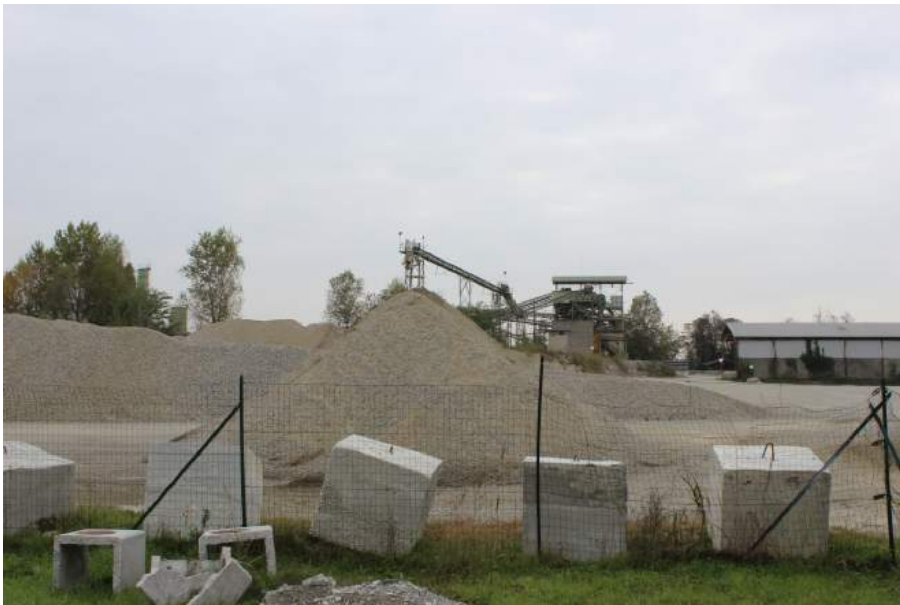
FOTO 13 – VISTA DA VIA LEONARDO DA VINCI VERSO LA CAVA A SUD
