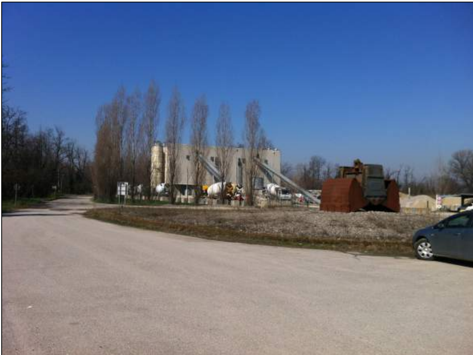
FOTO 27 - VEDUTA DELL'ATTUALE IMPIANTO PRODUTTIVO, VERSO EST
