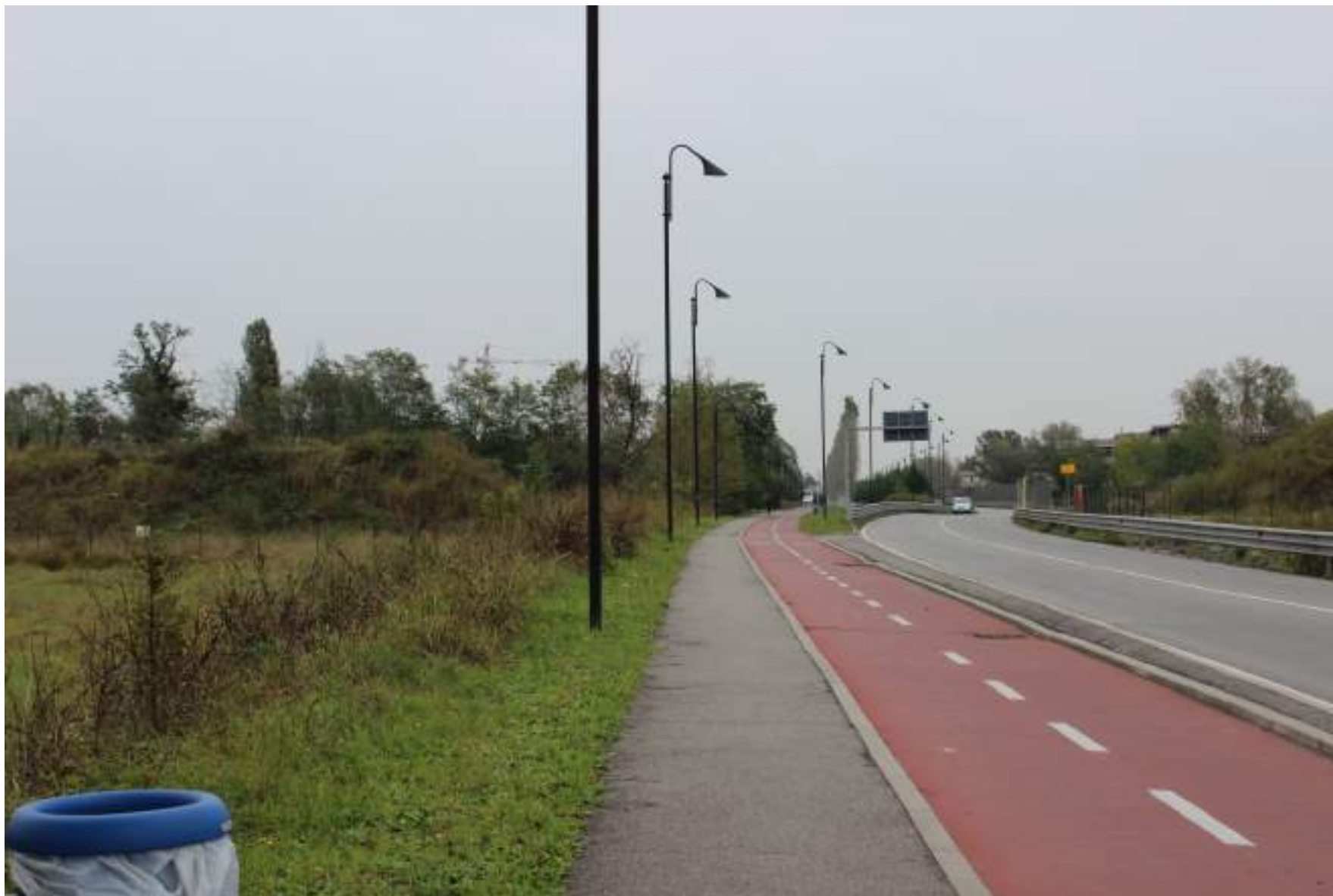
FOTO 37 - VISTA DI VIA REDECESIO VERSO ES
