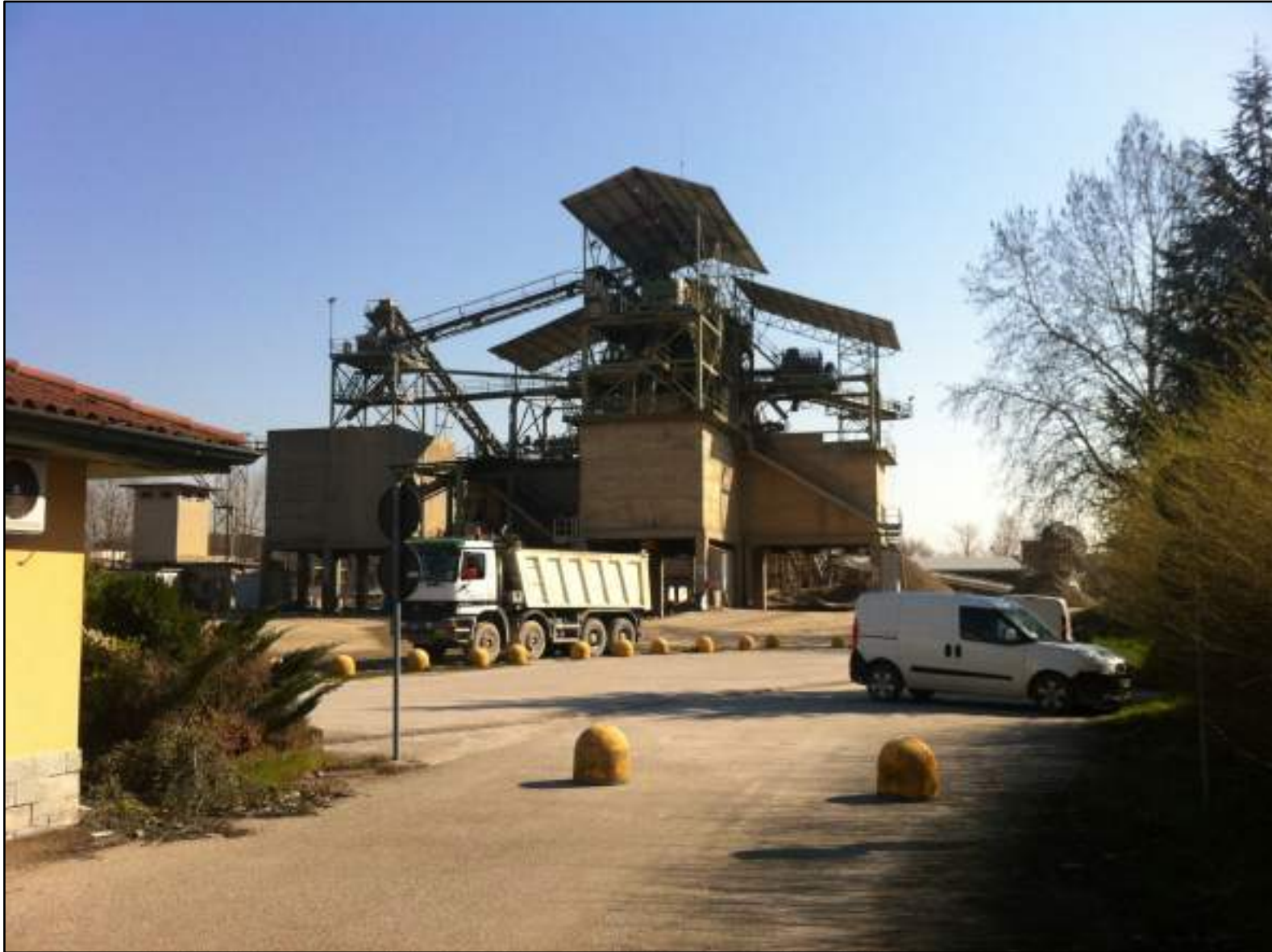
FOTO 28 - VEDUTA DELL'ATTUALE IMPIANTO PRODUTTIVO, VERSO EST
