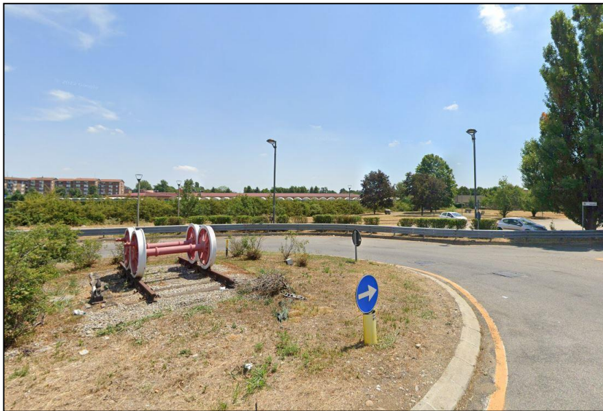
Fotografia – Rotatoria di Via Rivoltana-Via Novegro
